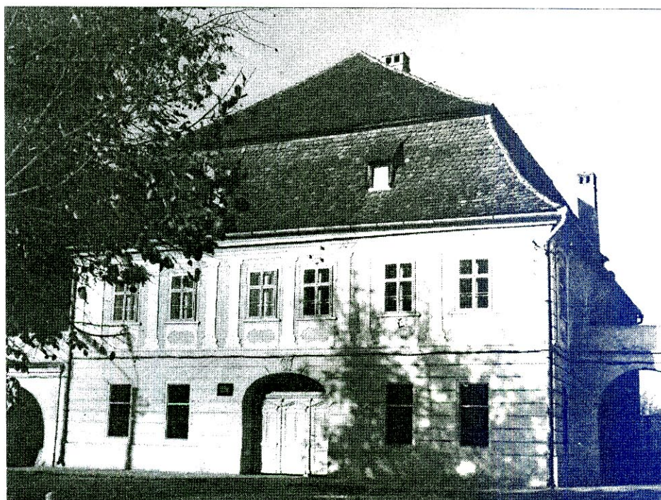
Fig. 2. Casa Zápolya – fațada sudică - după restaurarea din 1962 – 1964. (Sursa: Muzeul Municipal „Ioan Raica” Sebeș <<MMIRS>>, Fototeca , nr. inv. 684)
