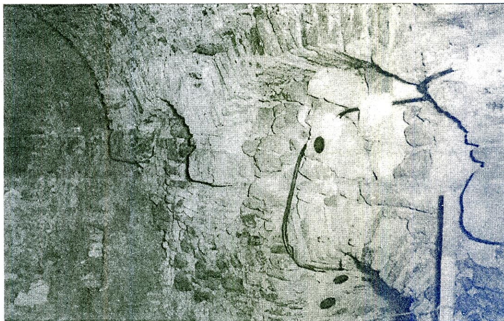
Fig. 12. Boltă semicilindrică cu penetrații, pe console – demisol (Sursa: MMIRS, Fototeca , nr. inv. 578)
