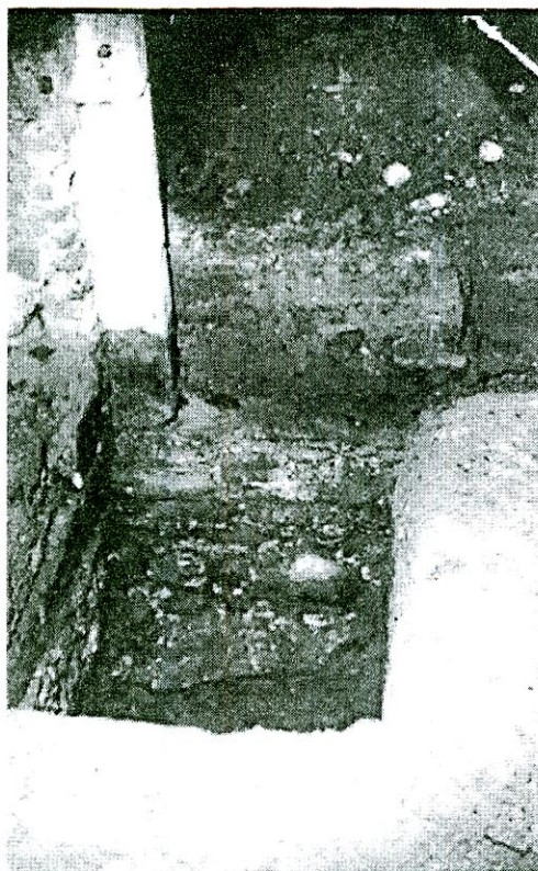
Fig. 4. Casetă deschisă la baza ancadramentului de ușă – demisol; 1962. (Sursa: MMIRS, Fototeca , nr. inv. 590)
