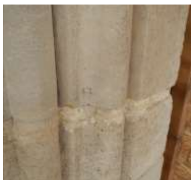
Fig. 7. Întregiri volumetrice cu ipsos de la intervențiile anterioare (detaliu de la portalul intrării principale) (V. Ștefan, 2016).
