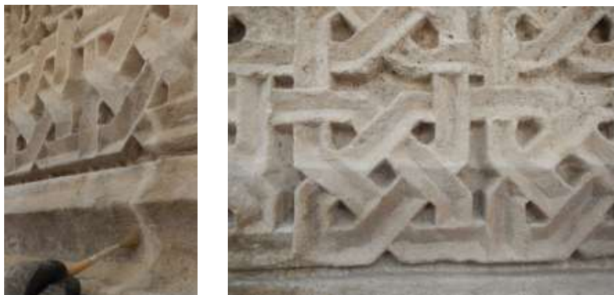
Fig. 12-13. Integrare cromatică, detalii din zona cu entrelacs-uri a fațadei vestice (V. Ștefan, 2016).
