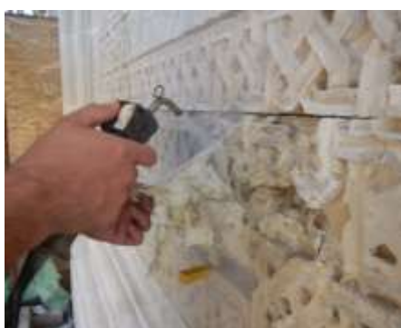
Fig. 9-10. Curățarea adezivului temporar cu ajutorul steamer-ului (după remontarea blocurilor de piatră din apropiere) în partea stângă a portalului (V. Ștefan, 2016).
