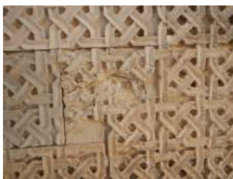
Fig. 9-10. Curățarea adezivului temporar cu ajutorul steamer-ului (după remontarea blocurilor de piatră din apropiere) în partea stângă a portalului (V. Ștefan, 2016).
