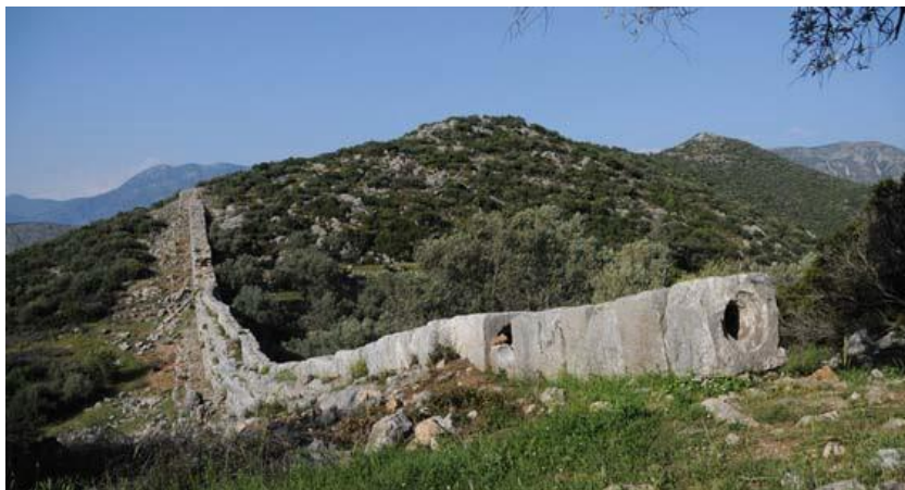
Fig. 5. Conducta din blocuri de piatră a sifonului de la Petara (după Mays, Ancient Water Technologies , p. 247).
