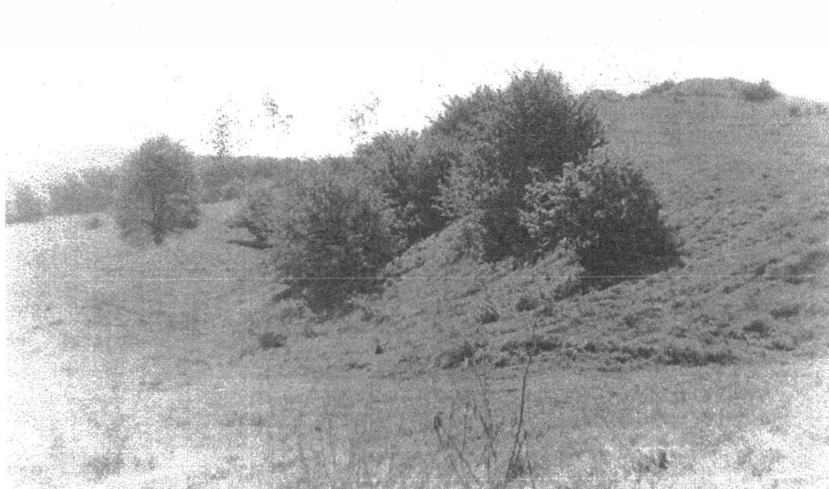
Fig.4. Valul mic și valul-parapet văzut de la poarta de pe latura de ENE
